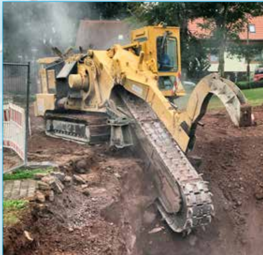
Seit 5. Oktober ist eine schwere Felsfräse im Parkgelände in Altenbergen im Einsatz, um Platz für den Stauraumkanal zu schaffen. Foto: Zweckverband
