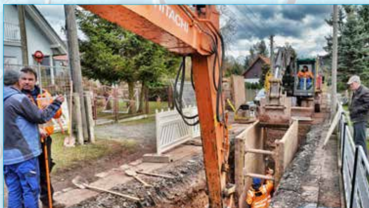
Polier Marko Schwanebeck (2. v. l.) und seine Leute von der WBB Straßen- und Tiefbau GmbH Marksuhl graben sich seit Anfang Februar auf über 300 m bis 2,30 m tief durch die Georgenthaler Straße in Catterfeld für die neuen Wasser- und Abwasserleitungen – unter Aufsicht der Anwohner (r.).
