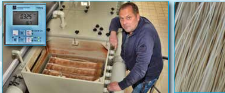
Azurblau – so zeigt sich das Trinkwasser nach seiner Aufbereitung, bevor es zum Hochbehälter Gottlob gepumpt wird (o.). Werkleiter Jürgen Kehl an einem der fünf Filter (u.) mit den unzähligen Teflonröhrchen.
