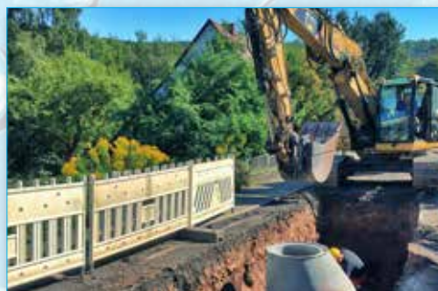
Die Baustelle in der Nikolaus-Brückner-Straße im Ortsteil Altenbergen. Foto: Zweckverband
